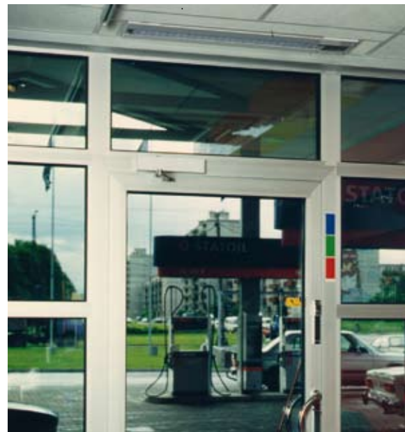
Установка в подвесной потолок
