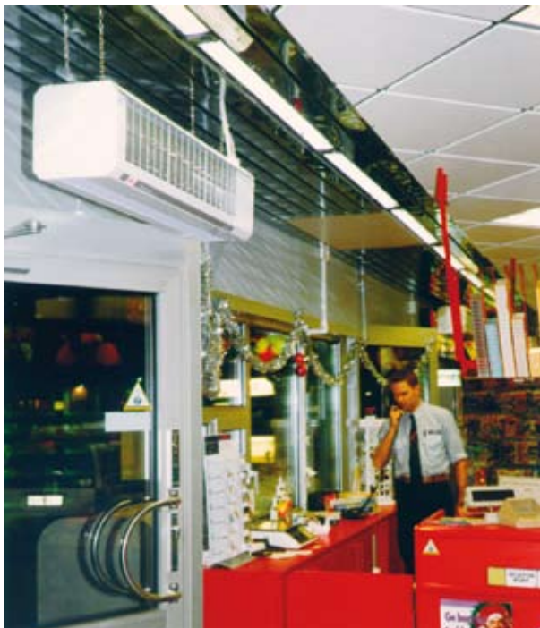
Крепление к потолку на стержнях
